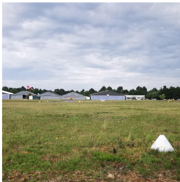
Figure 17 : Bâtiments de l'aéroclub - 31/05/21 - EU
