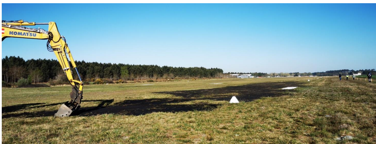
Figure 3 : Travaux sur la piste en avril - 07/04/21 - EU
