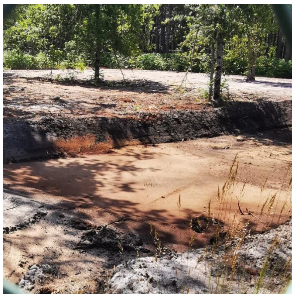
Figure 16 : Terrassement créé pour récupérer l'eau - 31/05/21 - EU
